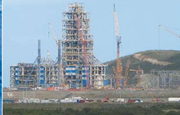
Les travaux de l'usine du Nord avancent (page 5).
